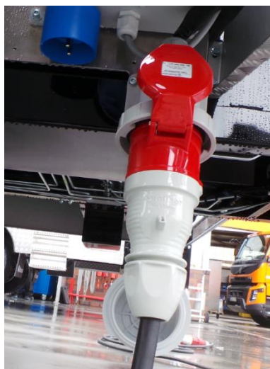
Afb. 8-28 CEE-stekker met CEE-koppeling
